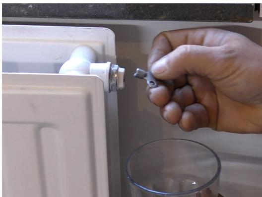
3. **Tournez légèrement la vis de purge** pour faire couler l'eau jusqu'à l'arrêt du sifflement de votre radiateur dû à l'évacuation d'air. Il s'agit ici de laisser échapper un bref filet d'eau, pas de vider toute l'eau du radiateur.
