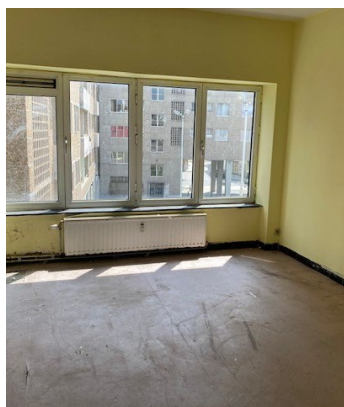
Appartement VOOR het in goede staat herstellen
