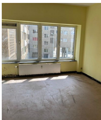
Appartement AVANT la remise en état
