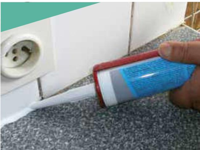
4. **Appliquez le silicone à 45°** le long du mur et sans déborder. Le filet doit être fin et régulier. Il ne sert à rien de réaliser un joint trop épais, cela n'améliore pas l'étanchéité.
