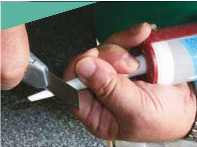
3. **Placez la cartouche à silicone dans votre pistolet.** Débloquez le levier et coupez l'embout à l'aide du cutter à 45° pour faciliter l'application du silicone.
