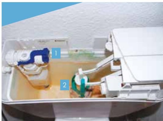
**Le premier joint se trouve à l'intérieur du mécanisme d'entrée d'eau.**
