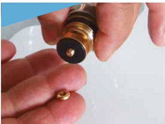
3. **Retirez la vis** de la pièce. Pensez auparavant à mettre le bouchon dans l'évier/le lavabo pour ne pas perdre de pièces.
