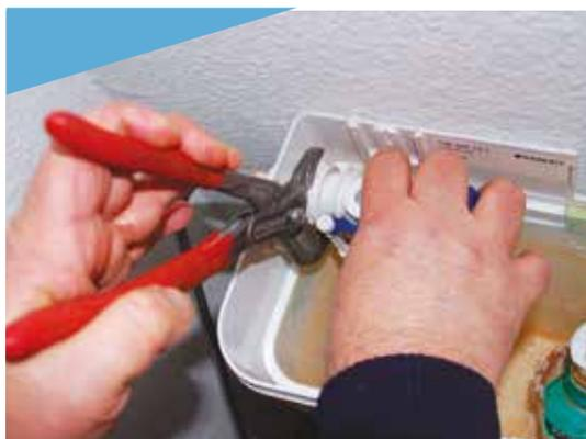
2. **Dévissez le mécanisme** d'entrée d'eau à la main ou à l'aide d'une pince.
