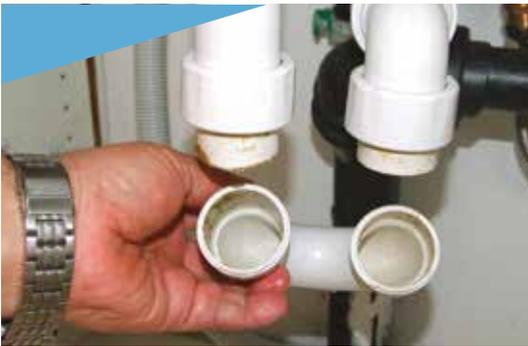
2. **Débarrassez le siphon des déchets** à l'origine du bouchon. C'est souvent à cet endroit que les bouchons se forment.
