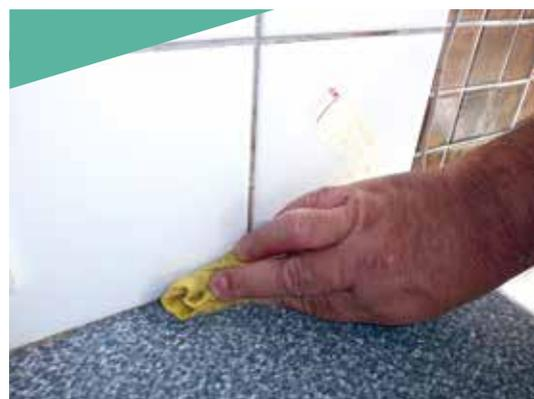
2. **Nettoyez la surface** avec un simple produit ménager pour décoller les résidus de joints. Une fois que la surface est propre, **séchez à l'aide d'un chiffon**. Veillez à ce que la surface soit totalement sèche avant d'appliquer le nouveau joint.
