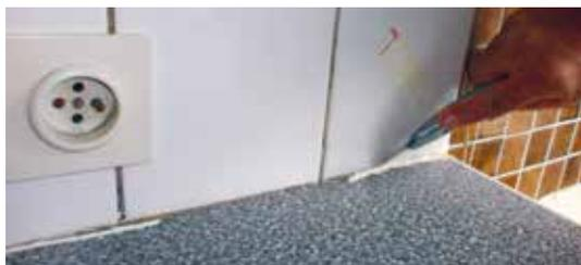
1. **À l'aide d'un cutter, décollez le joint en silicone** en faisant glisser la lame de chaque côté du silicone (en dessous et au-dessus). Si votre joint ne se décolle pas, laissez agir un solvant pour le décoller définitivement. Enlevez le joint décollé en tirant dessus.
