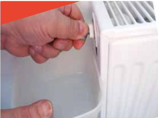
Dès que quelques gouttes d'eau commencent à sortir, laissez le purgeur ouvert encore quelques secondes puis **refermez-le** (il s'agit de faire échapper un bref filet d'eau, pas de vider toute l'eau du radiateur).
