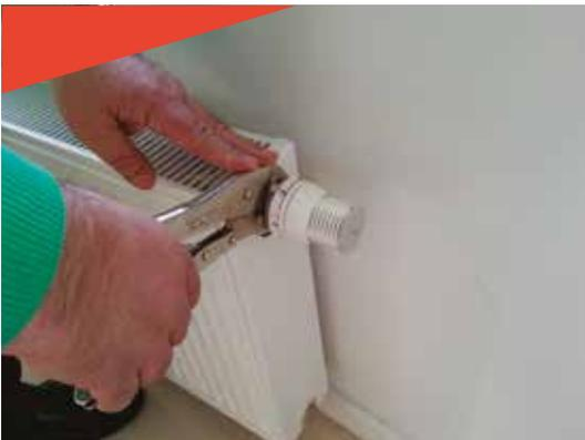
1. **Dévissez** la bague à la main ou délicatement avec une pince. Tournez-la dans le sens des aiguilles d'une montre.
