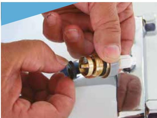
4. **Retirez le joint en caoutchouc** et **remplacez-le par un joint neuf** du même modèle. Pour être sûr d'acheter le bon joint, pensez à prendre le vieux joint avec vous au magasin.
