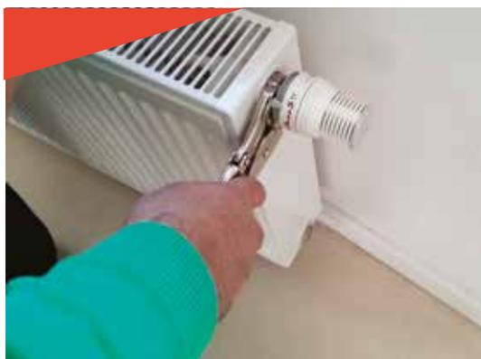
5. **Revissez la bague à la main** et serrez légèrement la bague avec la pince.
