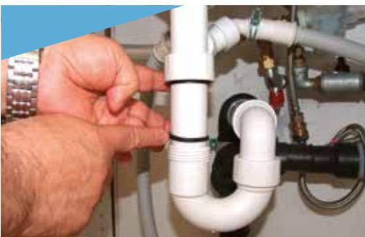
3. **Revissez le siphon** en veillant à ce que les joints soient placés de manière bien droite pour éviter toute fuite. Si nécessaire, vous pouvez également en profiter pour les remplacer.
