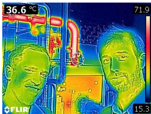
Photo prise à l'aide d'une caméra thermique : les responsables énergie devant une chaudière
